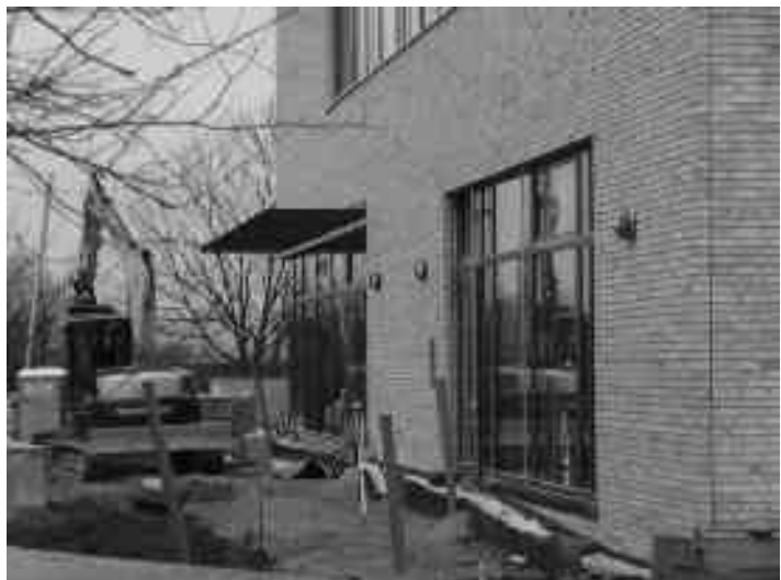
Die Bauarbeiten sind fast abgeschlossen.
